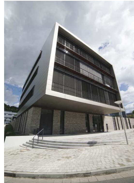
Der Forschungsneubau des „Abbe Center of Photonics“ (ACP) der Friedrich-Schiller-Universität Jena.
